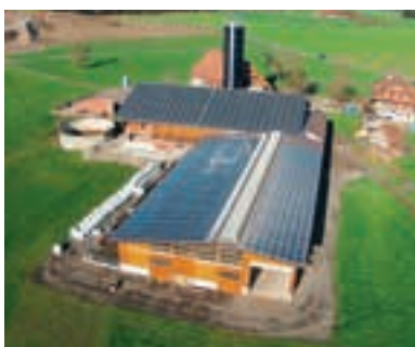
Kraftwerk auf dem Dach: Der Hof der Familie Bucher mit Solaranlage.
